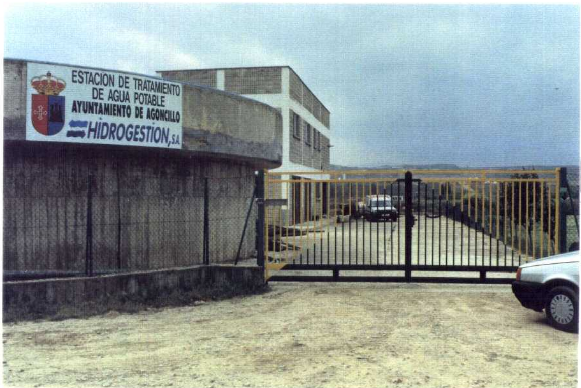
DEPURADORA DE AGONCILLO Y DEPOSITOS DEL POLIGONO AL FONDO.
